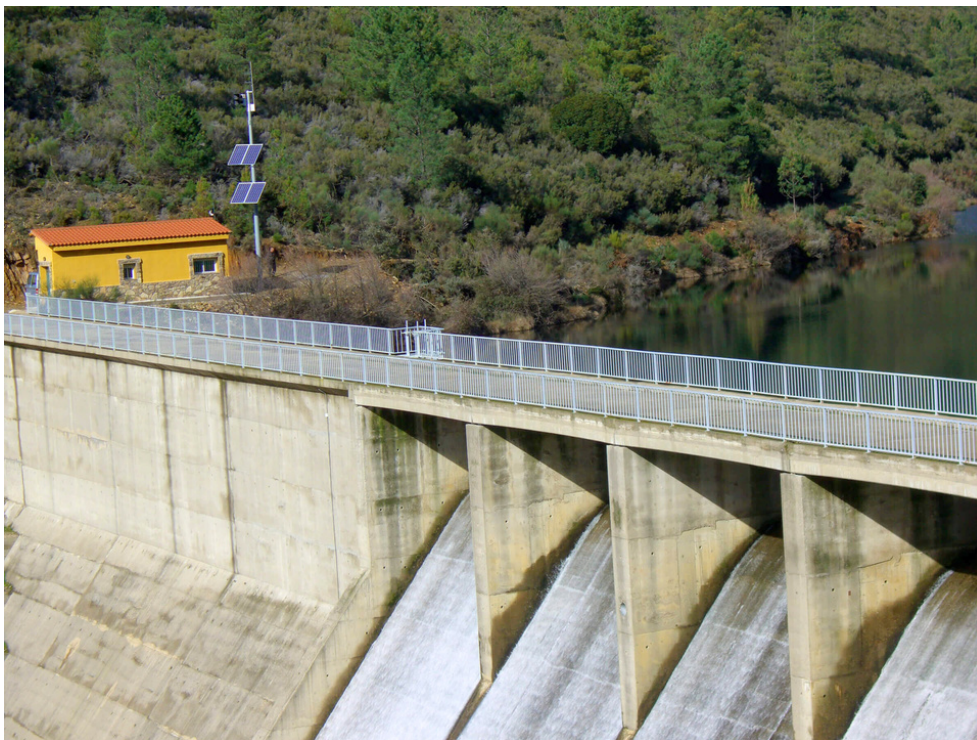
Gracias a la solución de Adasa cada presa dispone de toda la infraestructura necesaria.
