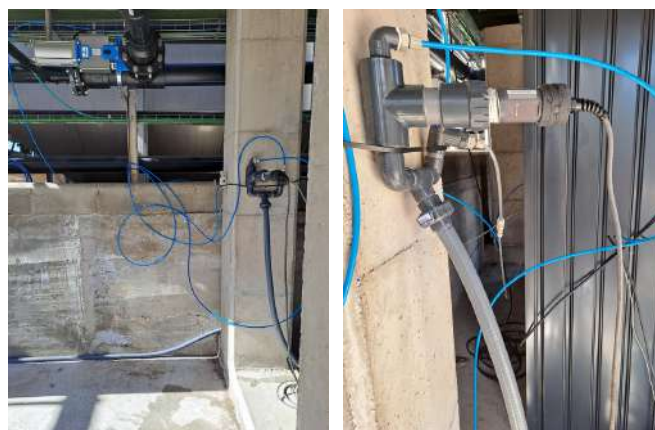
El sistema instalado por Adasa incluye los sensores microbiológicos aquaBio y aquaTest-MO, desarrollados por Adasa.
